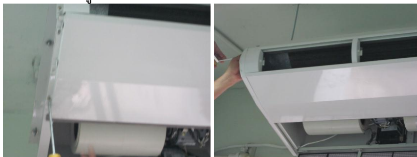
รูปที่ 3.2-17 การประกอบ Front Panel และ Side Panel
