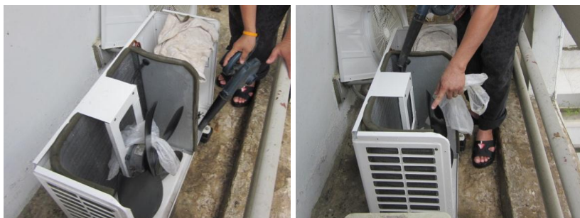
รูปที่ 3.2-21 การล้างทำความสะอาดเครื่องตัวนอก
