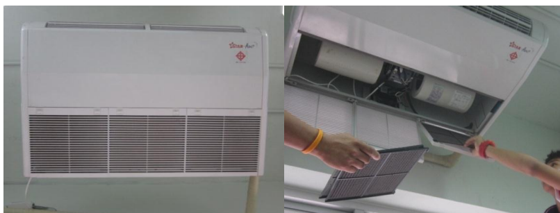
รูปที่ 3.2-3 การถอดแผ่นกรองอากาศ
