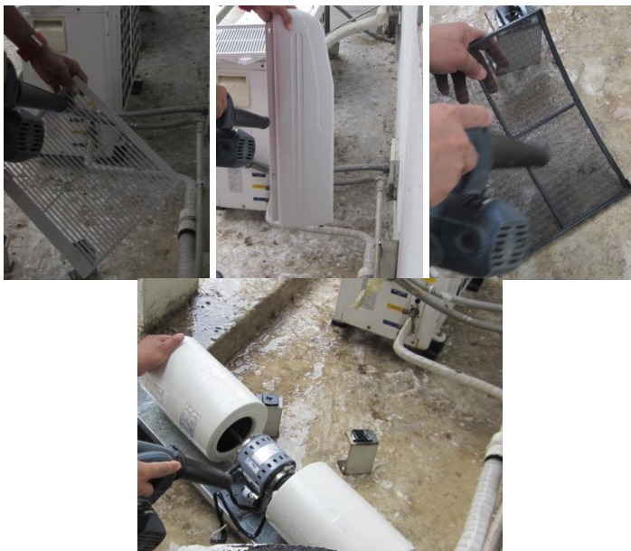
รูปที่ 3.2-10 การเป่าไล่ความชื้นจากตัวเครื่อง
