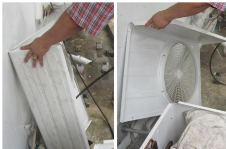
รูปที่ 3.2-20 การล้างทำความสะอาดเครื่องตัวนอก
