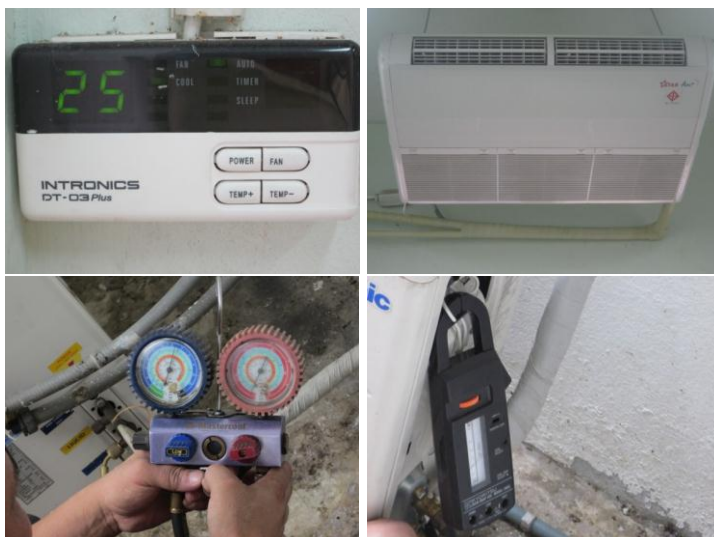
รูปที่ 3.2-23 การทดสอบเครื่องปรับอากาศ
