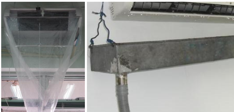
รูปที่ 3.2-8 การเตรียมการล้างทำความสะอาด
