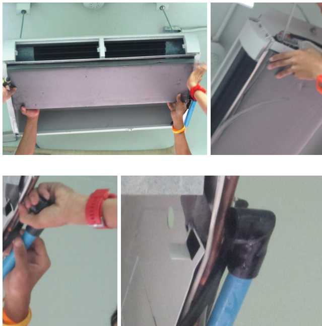
รูปที่ 3.2-14 การประกอบถาดรองน้ำ
