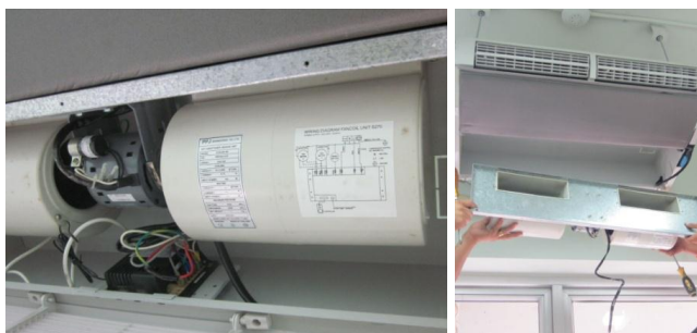
รูปที่ 3.2-5 การถอดพัดลมและมอเตอร์
