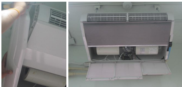
รูปที่ 3.2-4 การถอดหน้ากากด้านหน้า
