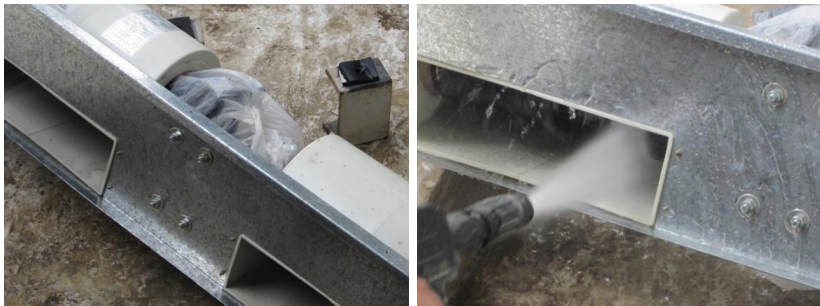
รูปที่ 3.2-9 การล้างทำความสะอาดอุปกรณ์ที่ถอดจากตัวเครื่อง
