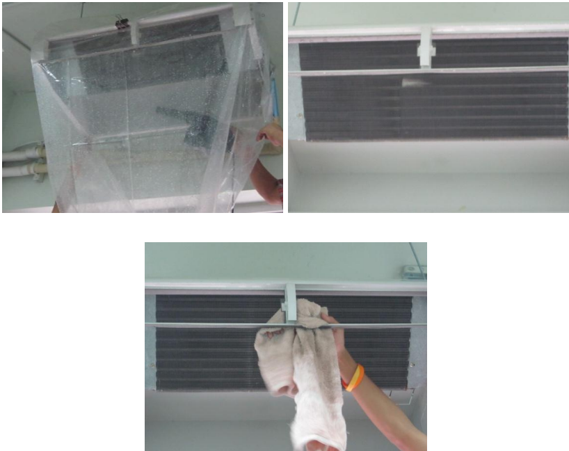
รูปที่ 3.2-13 การเป่าแผงคอยล์ Heat Exchanger
