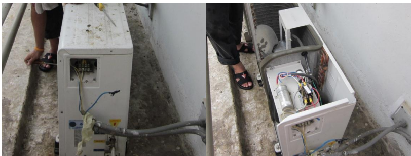
รูปที่ 3.2-18 การถอดฝาครอบด้านหน้า
